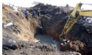
Іл. 34.11. Викопування водовідвідної каналу
