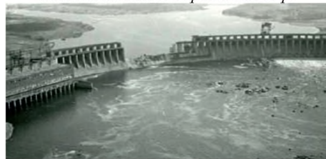
Іл. 33.7. Зруйнована вибухом гребля Дніпрогесу в 1941 р.
